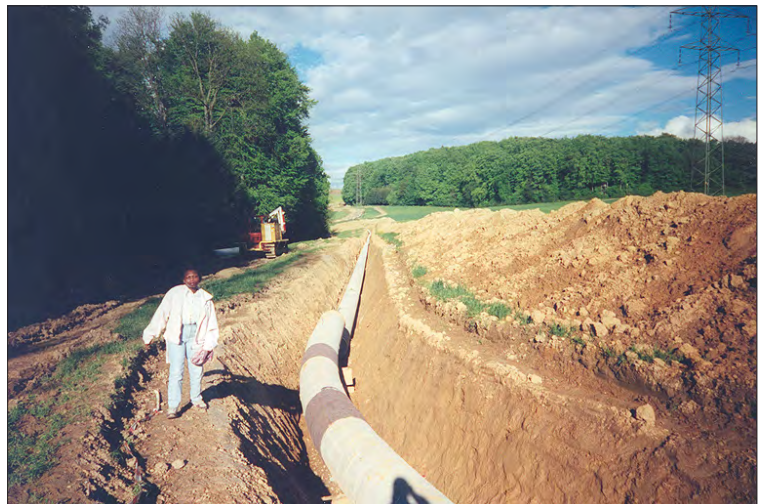
Stand der Bauarbeiten im Mai 1997. Die Erzhöhle führt im Bereich der Baumaschine im Hintergrund unter der Gasleitung hindurch.
