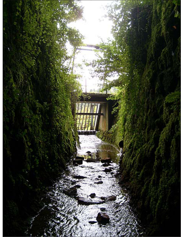
Blick vom Eingang zurück zum Einlaufrechen.
