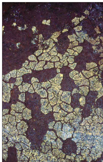
Schimmelpilze aller Farben auf einer von Trockenrissen geprägten Lehm-schicht schmücken die Wände (hier Ubuvumo Ruhombo).
